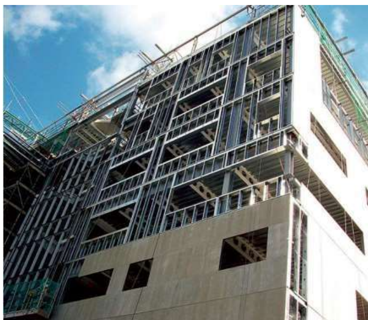
Figura 7 - Exemplo do método contínuo
