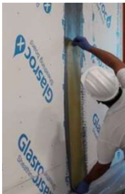
Figura 42 - Aplicação da tela de reforço
