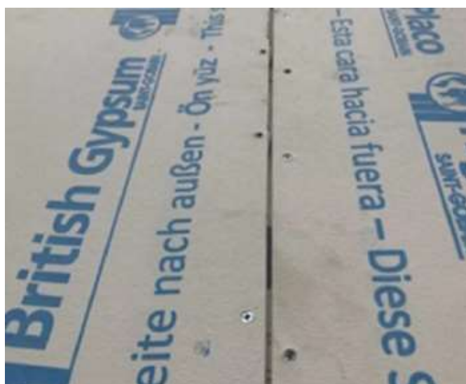
Figura 31 - Detalhamento dos parafusos
