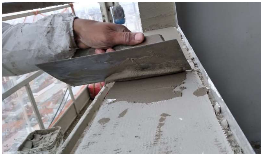
Figura 34 - Camada de argamassa para caimento que será revestida com chapa de alumínio
