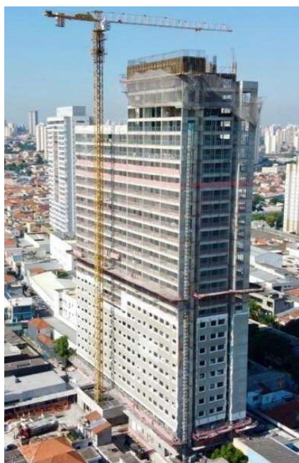
Figura 50 - Posicionamento da grua
