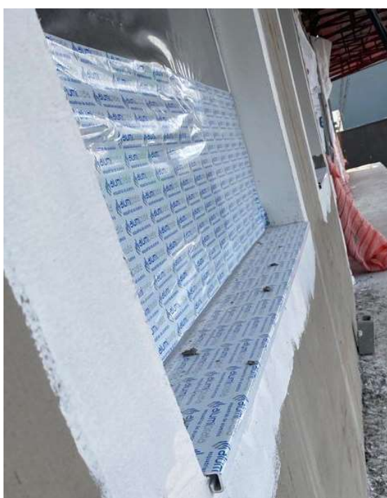
Figura 35 - Chapa em alumínio instalada formando o peitoril
