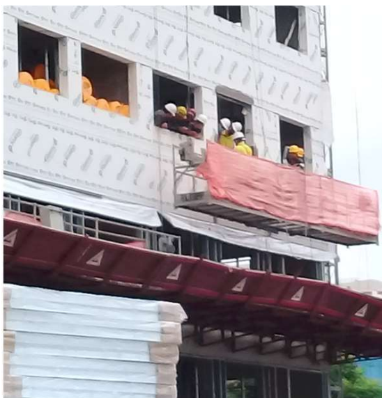
Figura 54 - Treinamento no balancim
