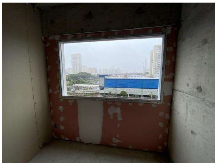
Figura 39 - Utilização de chapa RF no lado interno da vedação
